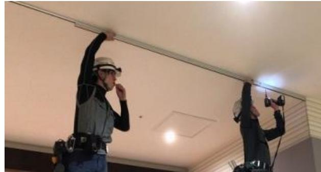
1 : 上部レールを改修の場合は既存レールの下に、新築の場合は下地確認し、**テックスビス(303ピッチ以内)**で取り付ける。
