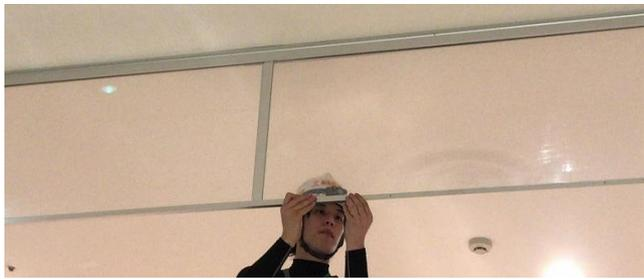
③：端部には付属の端部ジョイント金物を差し込み、最後に端部方立の隙間に飲み込ませ、端部方立へ突きつけて納める。(※下図参照)
